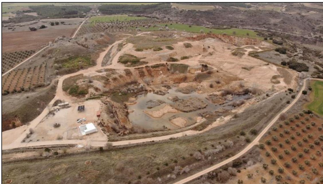
Figura 5. Vista general de La Chanta tras finalizarse el proceso de restauración
